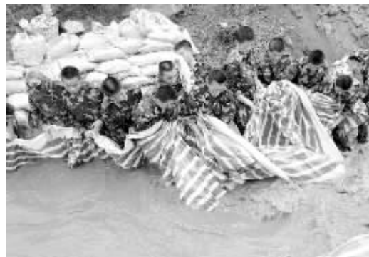
武警官兵堵死渗水口
