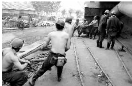
抢险人员正全力安装排水设备,抢排井下积水。
