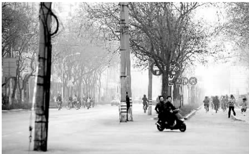
棉纺路扩路之后，很多电线杆从原来的路边站上了快车道。
