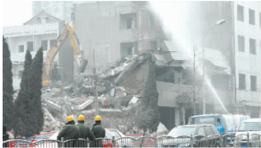
拆迁过程中,洒水车进行喷水降尘作业。
