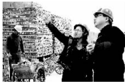
施工现场经常能看到李燕的身影
