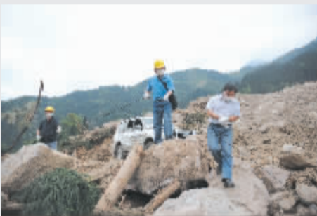
▲移动技术人员在灾区修复通信光缆
