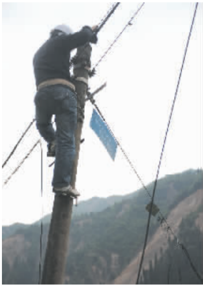
移动抢险分队在危险地段抢修线路
