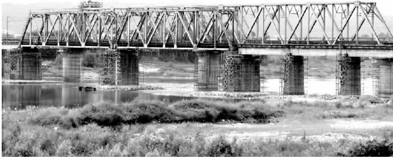
宝成铁路涪江大桥“一身盔甲”,严防唐家山堰塞湖洪水冲击。
