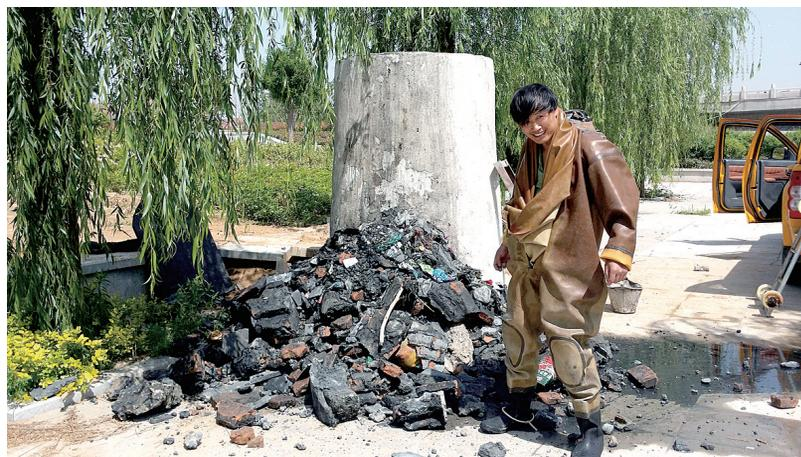
须水河堤岸上的污水井遭堵塞井壁出现破洞,井内污水喷涌而出源源不断地流向了河道之内,引来微博网友的关注和转发。昨日,市城市管理局出动多名“蛙人”,将积存在井底的建筑垃圾成功清理出来,使得污水继续沿井下管道流向五龙口污水处理厂。郑州晚报记者 汪永森 文/图
