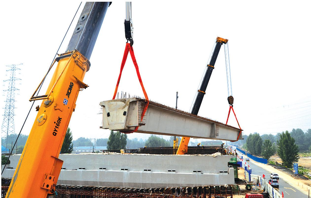
**本报讯** 郑州市107辅道快速化工程施工迎来新节点。15日,107辅道部分标段开始箱梁吊装。当天,第十联第三跨预制箱梁、第七联第二跨30米预制箱梁分别吊装到位,这是107辅道快速化工程首次实施箱梁吊装。
