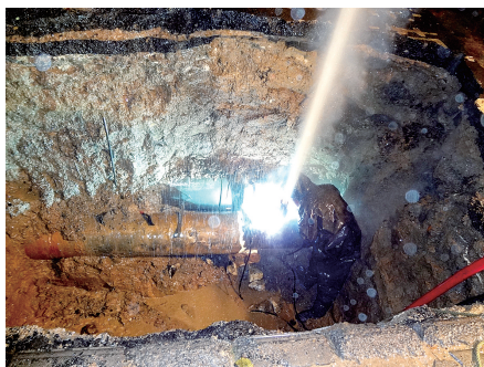
异常艰险的热力抢修现场
