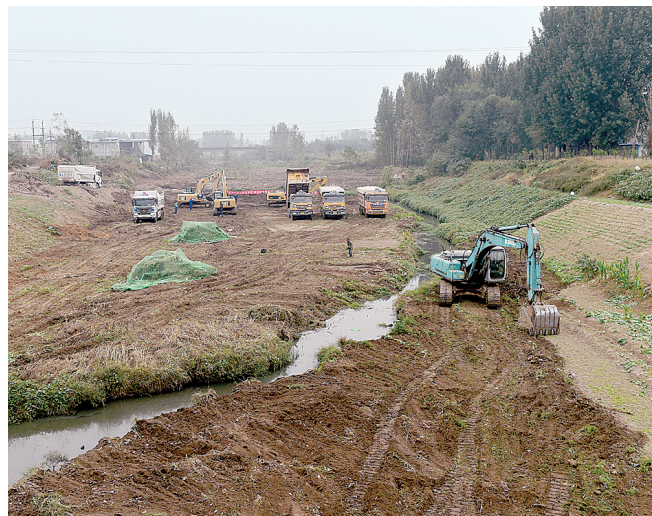
贾鲁河整治工程正在抓紧施工中
