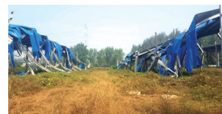
农业高新区拆除违建现场
