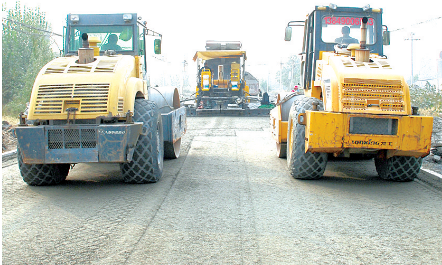
正在进行水稳铺装的X021马米线马沟至新G310段改建工程
