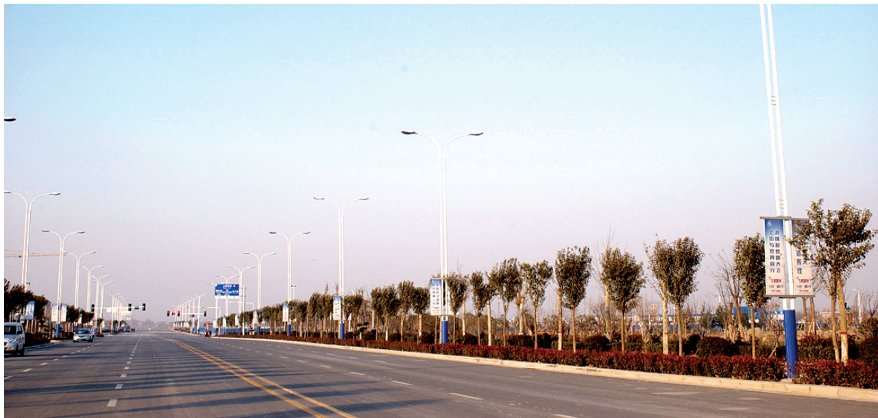
郑州通航试验区新建道路
