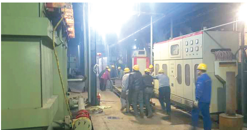
项目建设正在进行
