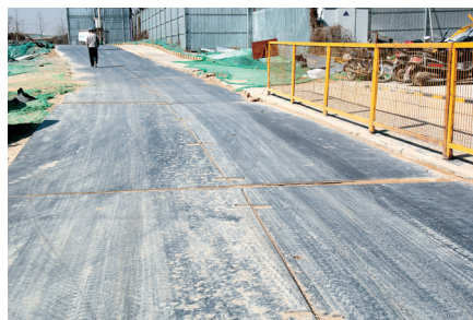
万科·美景魅力之城一工地大门口,施工方采用钢板方式代替硬化路面,效果较好
