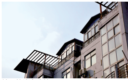
楼顶的违章建筑
