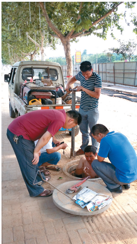
工作人员正在抢修下水道
