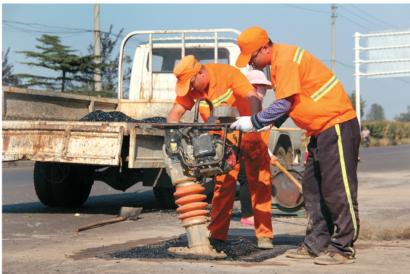
公路养护人员正在填补坑槽
