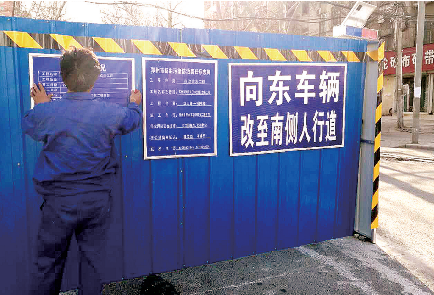
改造路段围挡已围好,工作人员张贴行车提示
