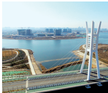
龙湖内环路跨北引水渠桥
