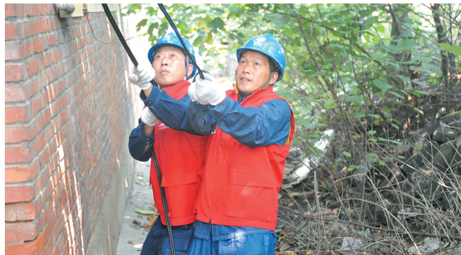
党员服务队积极投身电网建设,确保迎峰度夏安全稳定
