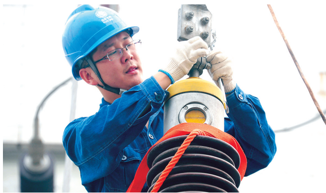
工作人员正在检修
