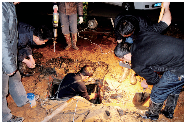
自来水公司连夜抢修供水管道
