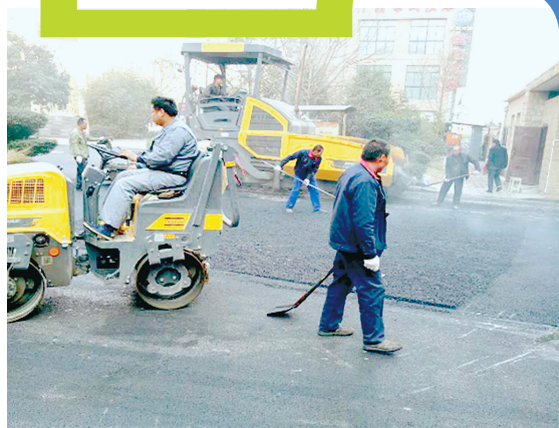
翻修破损道路
