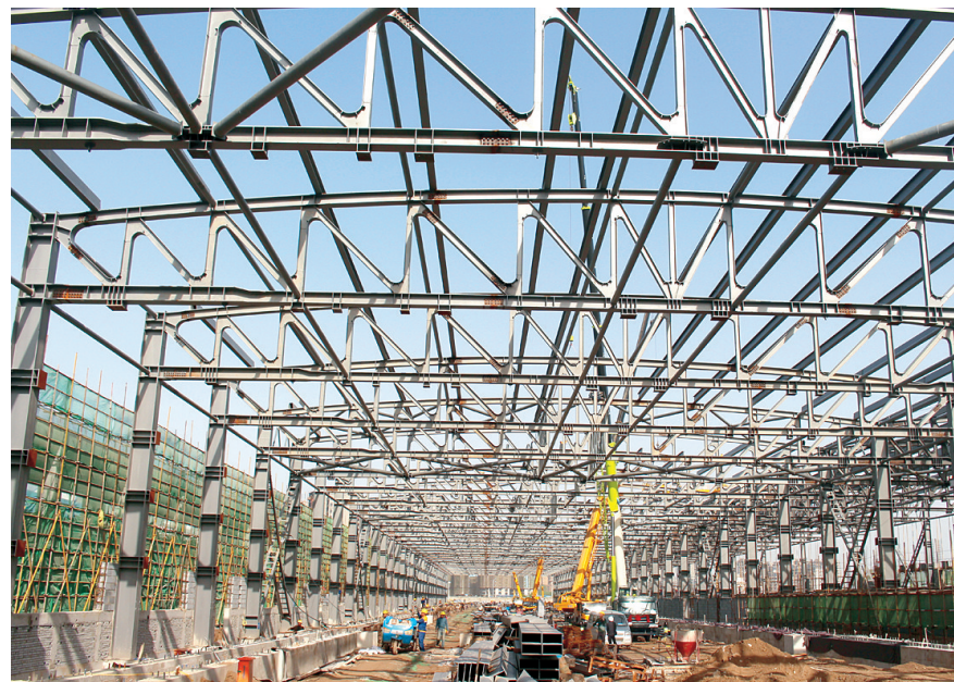
钢结构主体吊装完成
