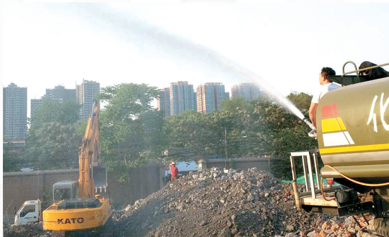
五一节放弃休息,监控工地施工
