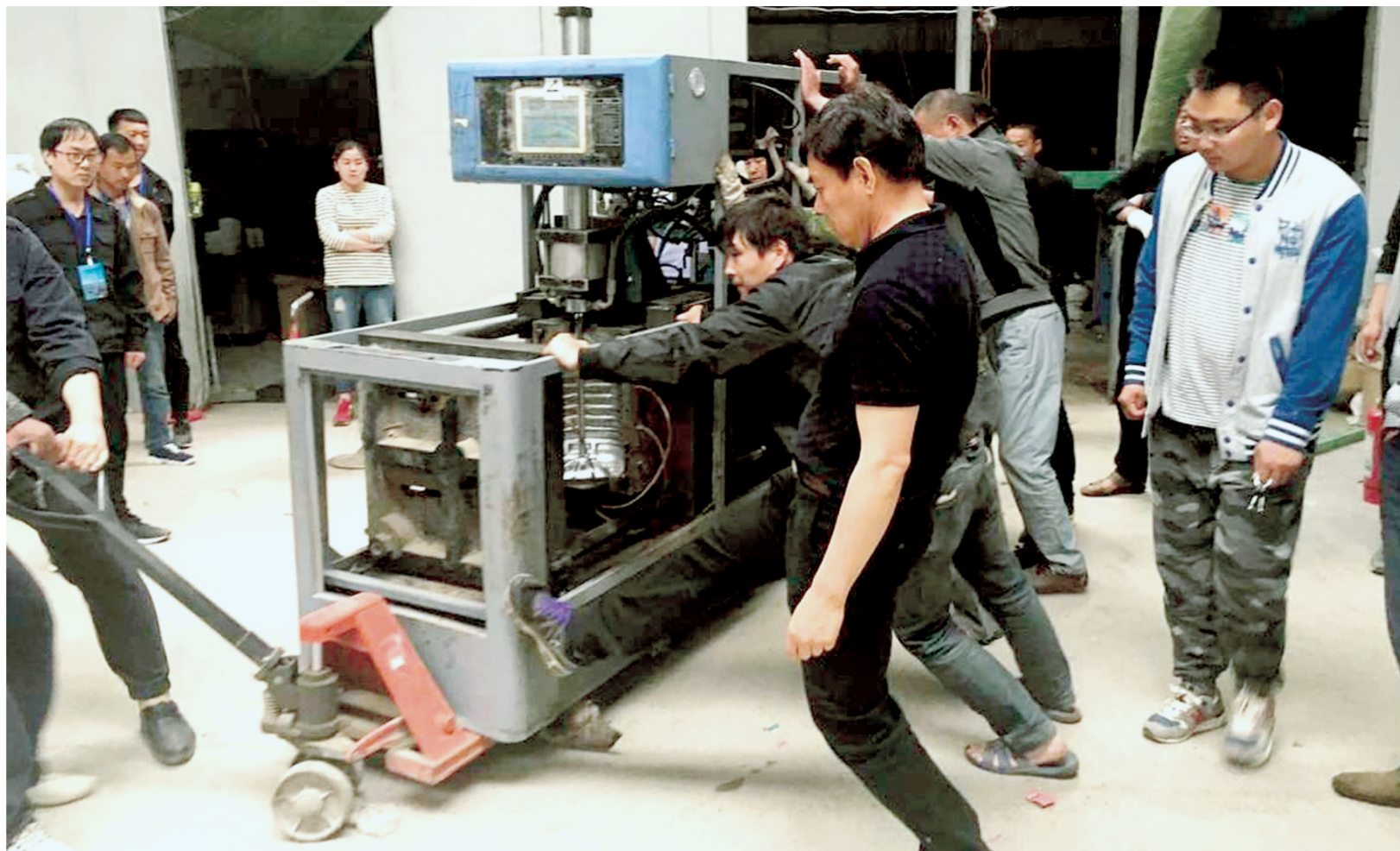
京航办事处拆除小塑料制瓶厂设备
