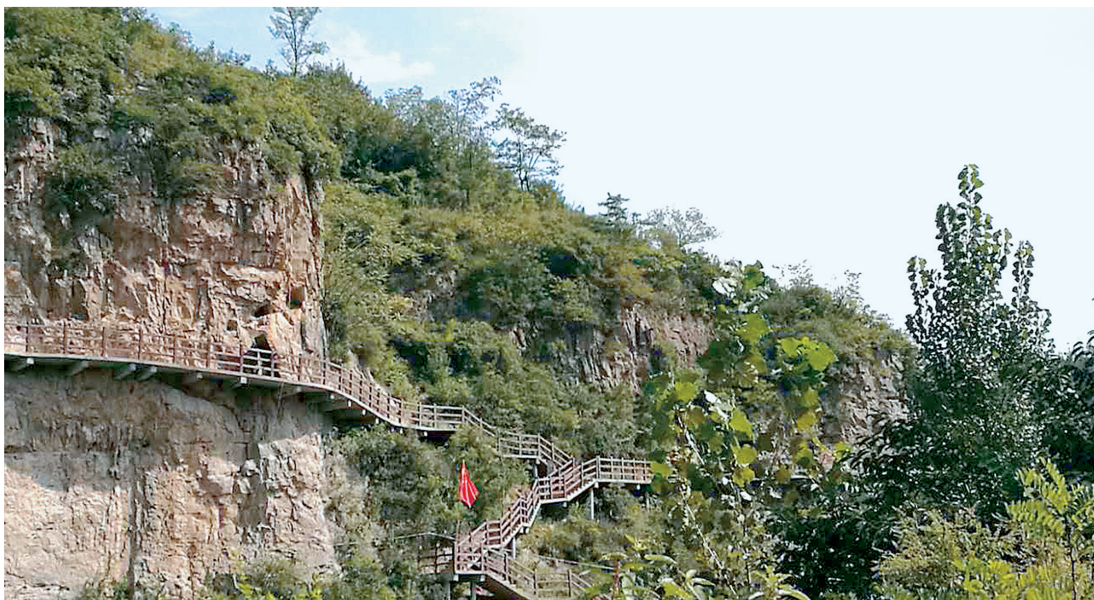
正在建设中的范家门景区。郑报融媒记者 武建玲 图
