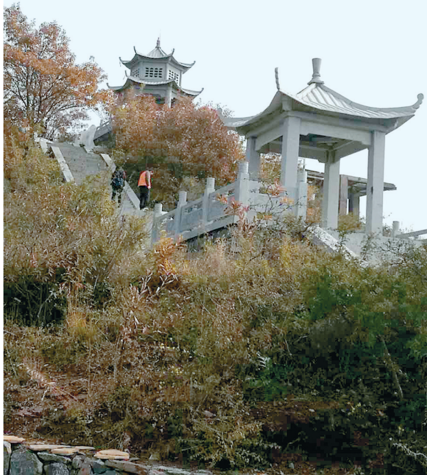
正在建设中的范家门景区
