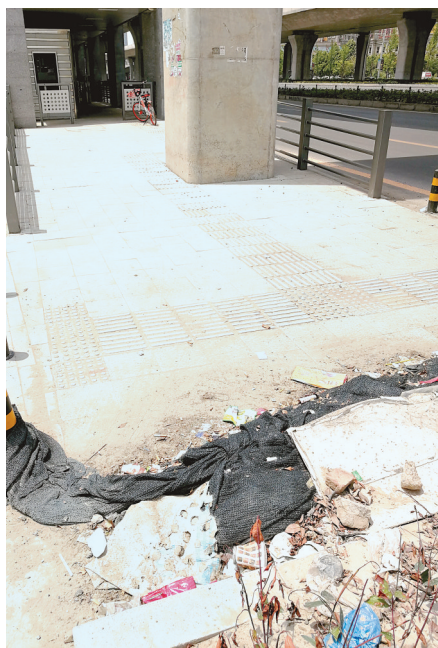
中州大道航海路口路旁垃圾
