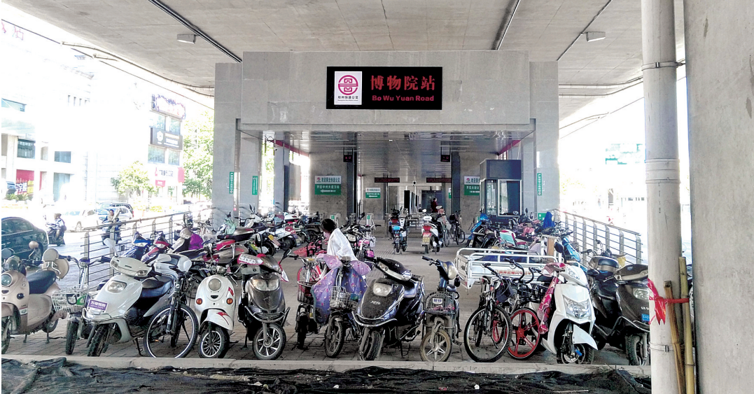
站台入口处被电动车占道
