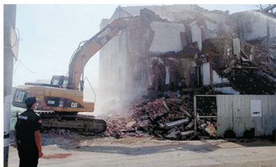
理,并将建筑垃圾及时覆盖防尘网,确保扬尘治理措施落实到位。
