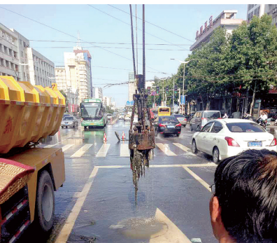
堵塞窨井的杂物被吊出
