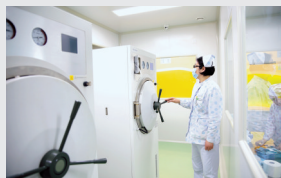
层流净化消毒供应室
