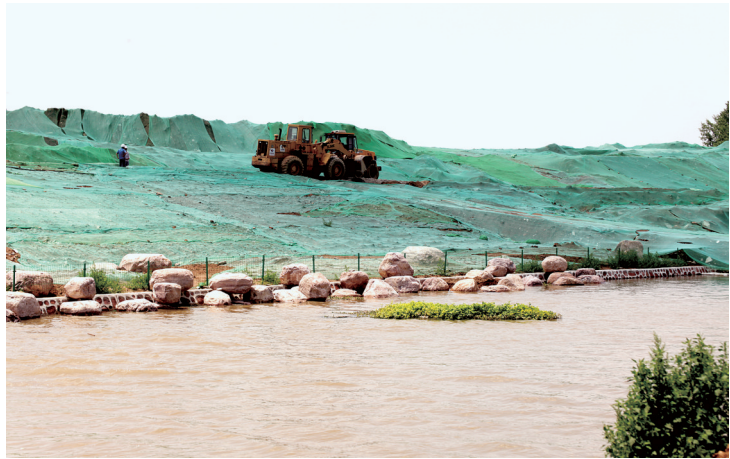
岸上都覆盖了防尘网
