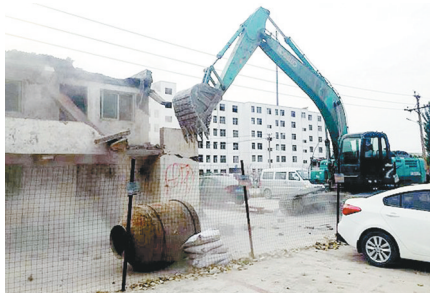
百炉屯村卫片图斑拆除现场
