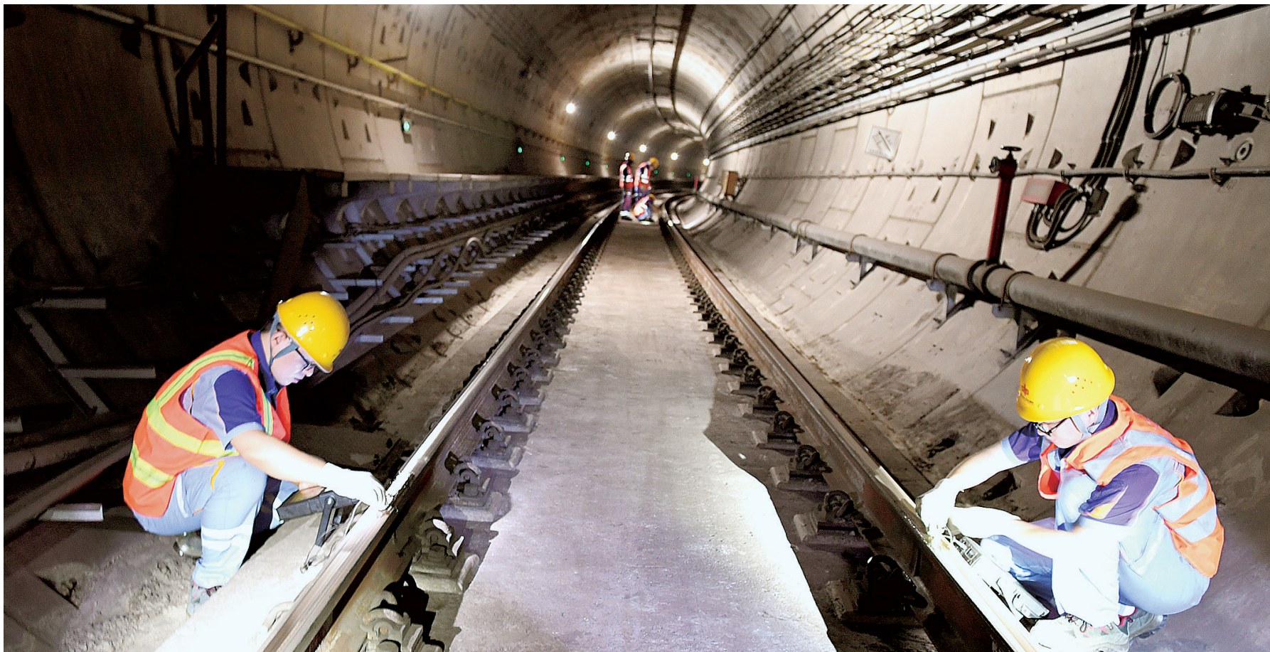
25米一对钢轨焊接点的探伤检查,两位技术人员需要10到20分钟的时间。
