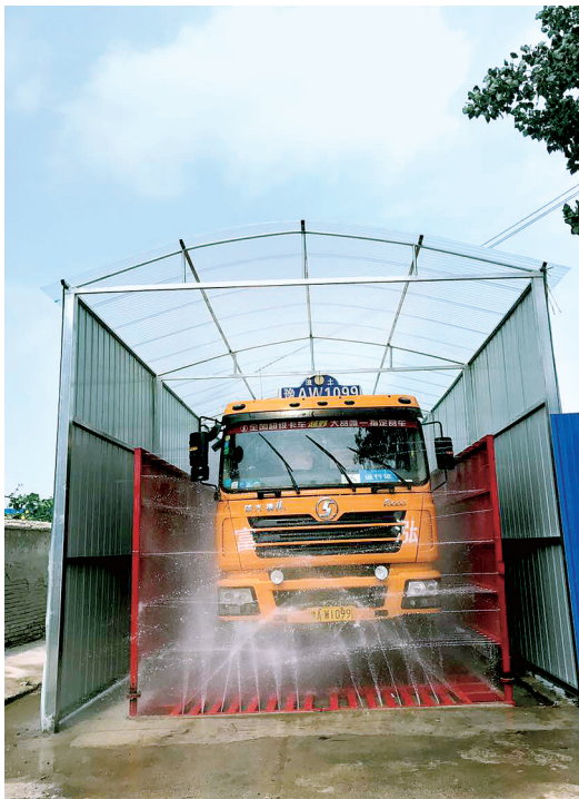
工地出口安装洗车台,对工程车“洗澡”
