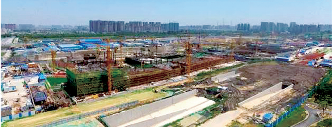
市民活动中心施工现场图
