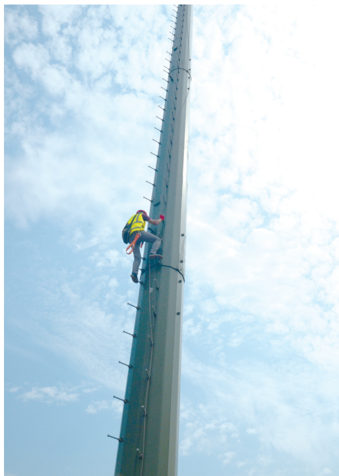
爬塔,调整天线
