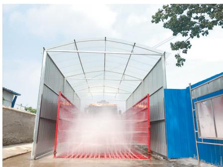
在经开区阳光城项目建筑施工现场,每个出口都安装了双洗车台,进入工程车辆都要通过双重冲洗,同时,工地内裸露黄土全部覆盖,工地四周围挡都安装了喷淋设施,24
