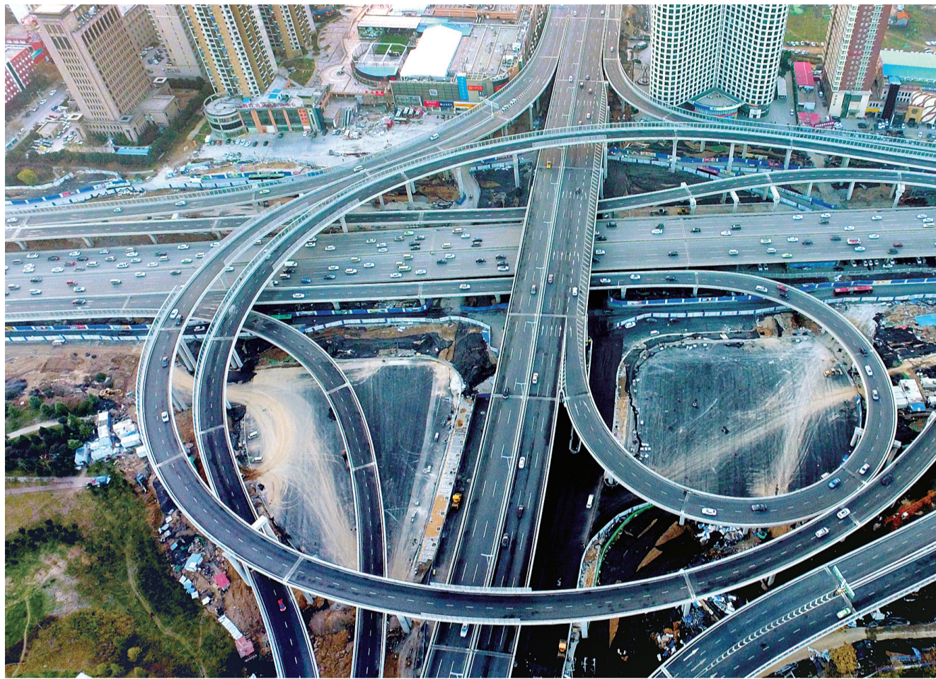
“井字+环线”快速路网体系基本形成,一批重大市政工程加快建设或建成投用
