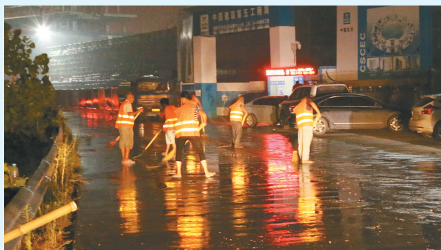
工地清扫保洁,24小时不间断
