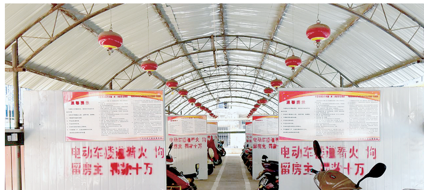
外观像灯笼的悬挂式干粉灭火装置
