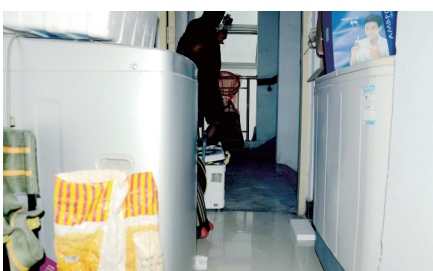
清水湾小区楼道被居民物品严重挤占
