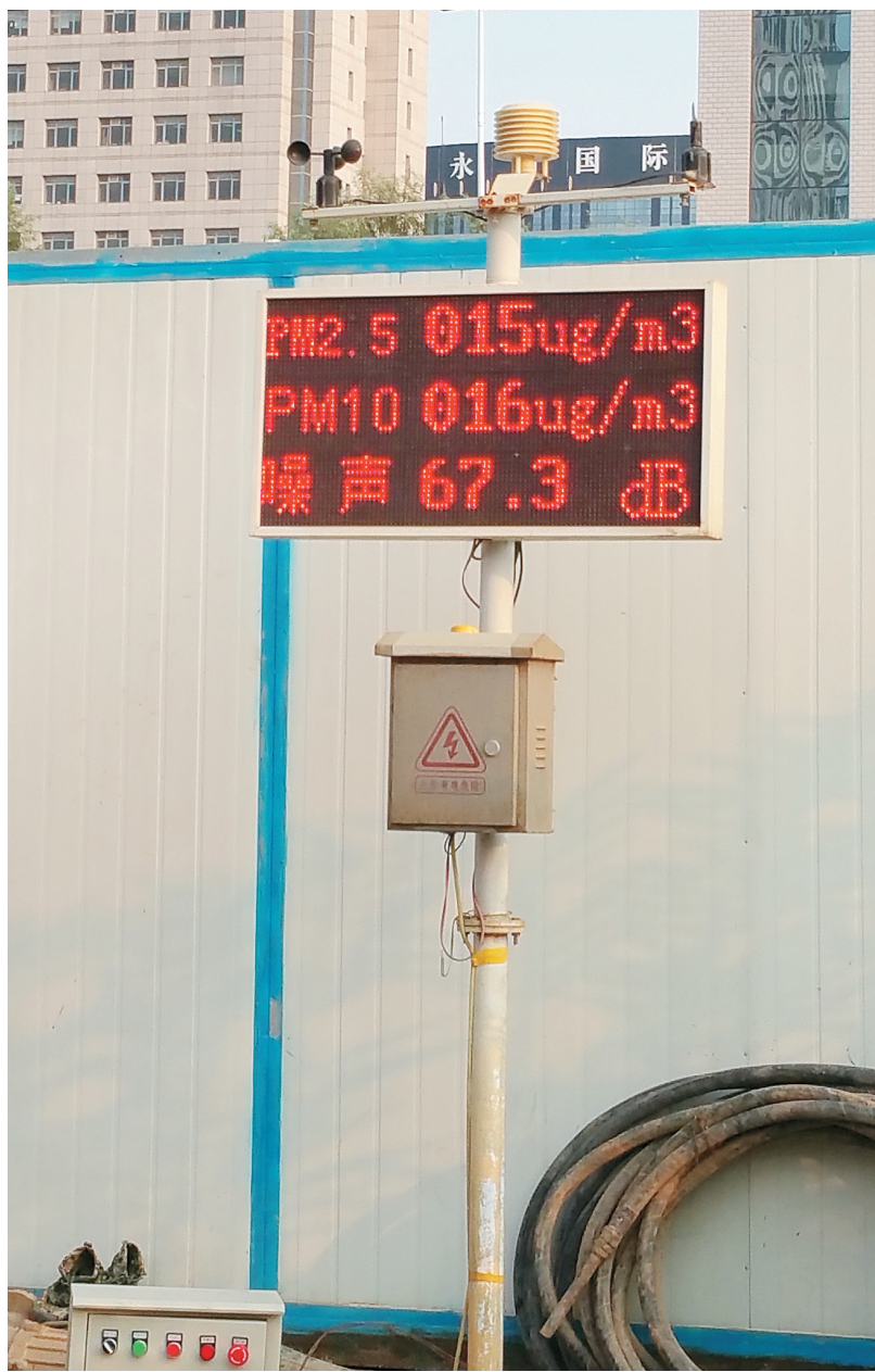
建筑工地启用“环境在线监测控制系统”,实时显示大气PM2.5、PM10、噪声等数据
