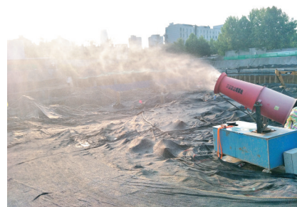
雾炮车上阵抑制扬尘净化空气
