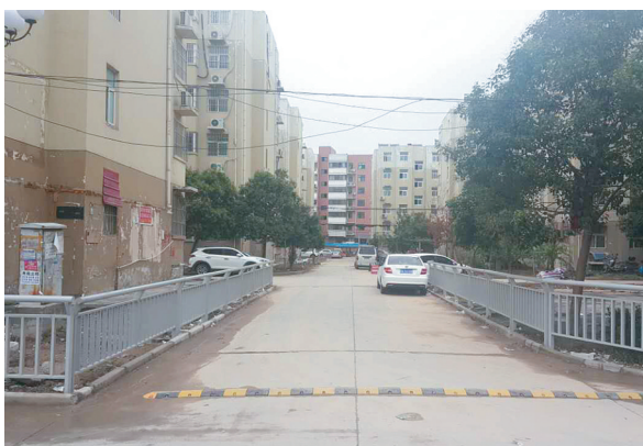
整改后的小区路面平整有序,还增加了护栏
