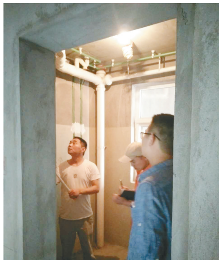
5号装修网验房、施工现场
