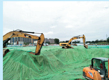
施工场地绿网覆盖
