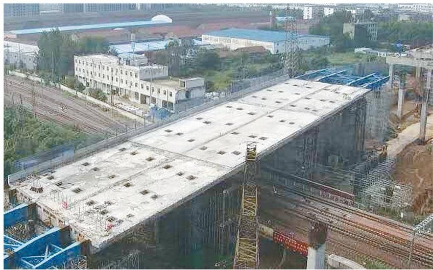
农业路跨京广铁路为预应力混凝土连续梁,宽57.5米,高2.4米,重约1万吨,采用左右分幅、单箱六室断面设计。设计采用柔性拖拉法顶推法施工,总顶推距离106米,跨营业线顶推距离40米,重量及幅宽均属国内首次。
